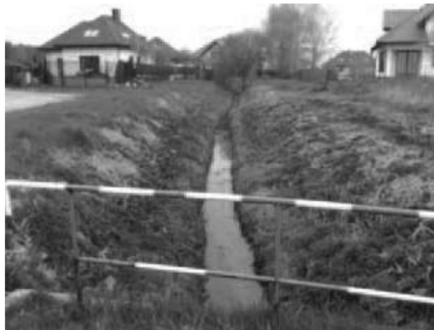
Widok – konserwacji rowu melioracyjnego w m. Niemcz – zakres prac – koszenie, hakowanie, odmulanie cieku.
