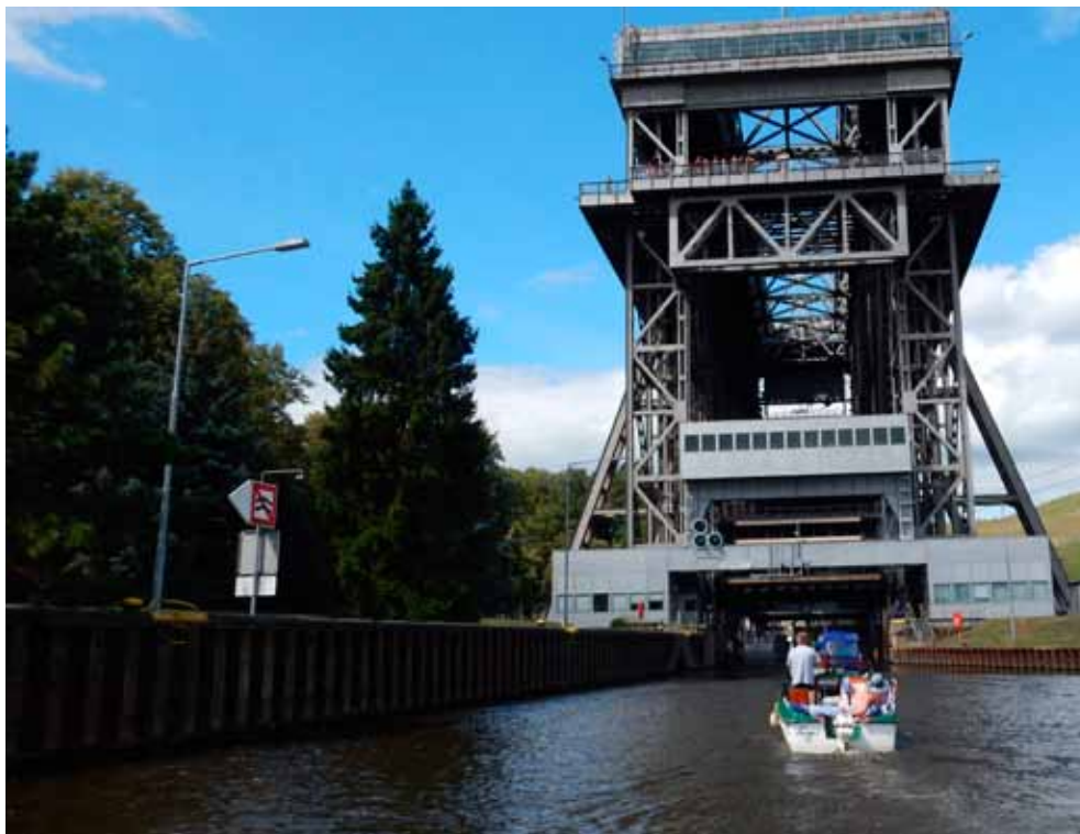
Podnośnia Niederfinow podnosi łódzie 36 m wyżej w wodnej wannie. Zbudowana w 1934 roku.
