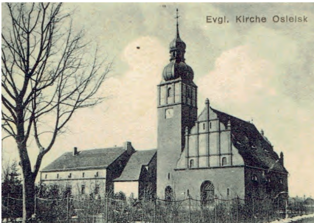
Na załączonej starej fotografii widać kościół ewangelicki w Osielsku w okresie jego świetności. Współcześnie budynek ten jest siedzibą Gminnego Ośrodka Kultury, a na miejscu dawnej pastorówki znajduje się budynek urzędu gminy. Fotografia pochodzi z prywatnych zbiorów mieszkańca gminy Osielsko.
