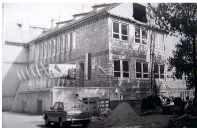
Gimnazjum w Żołędowie w budowie.
