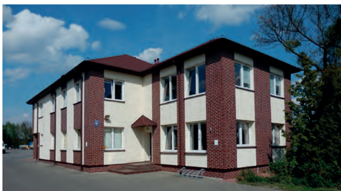
GZK przed i po rozbudowie.
