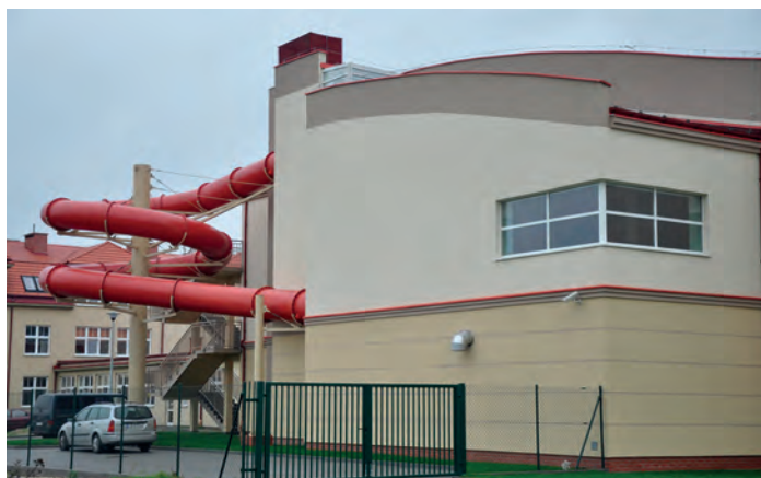
Na zdjęciach basen w trakcie budowy i ukończony.
