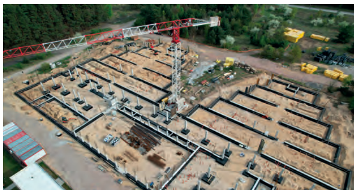
Budowa szkoły w Niemczu 2025 rok.
